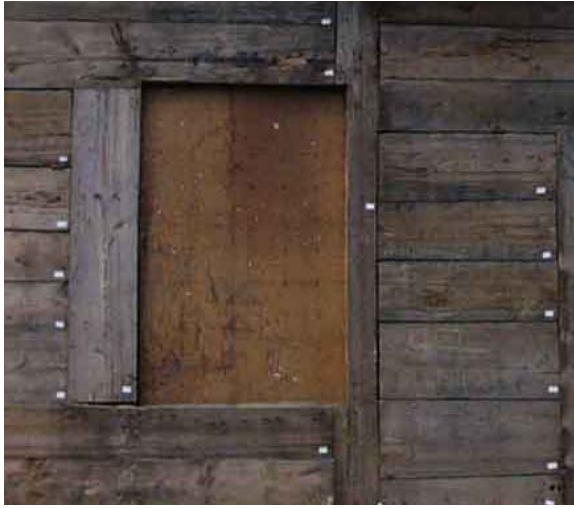
Assemblage tenon et mortaise en coulisse
