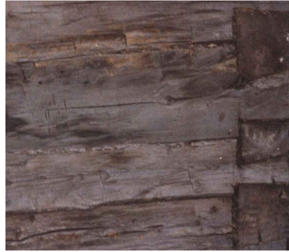
Assemblage à queue d'aronde
